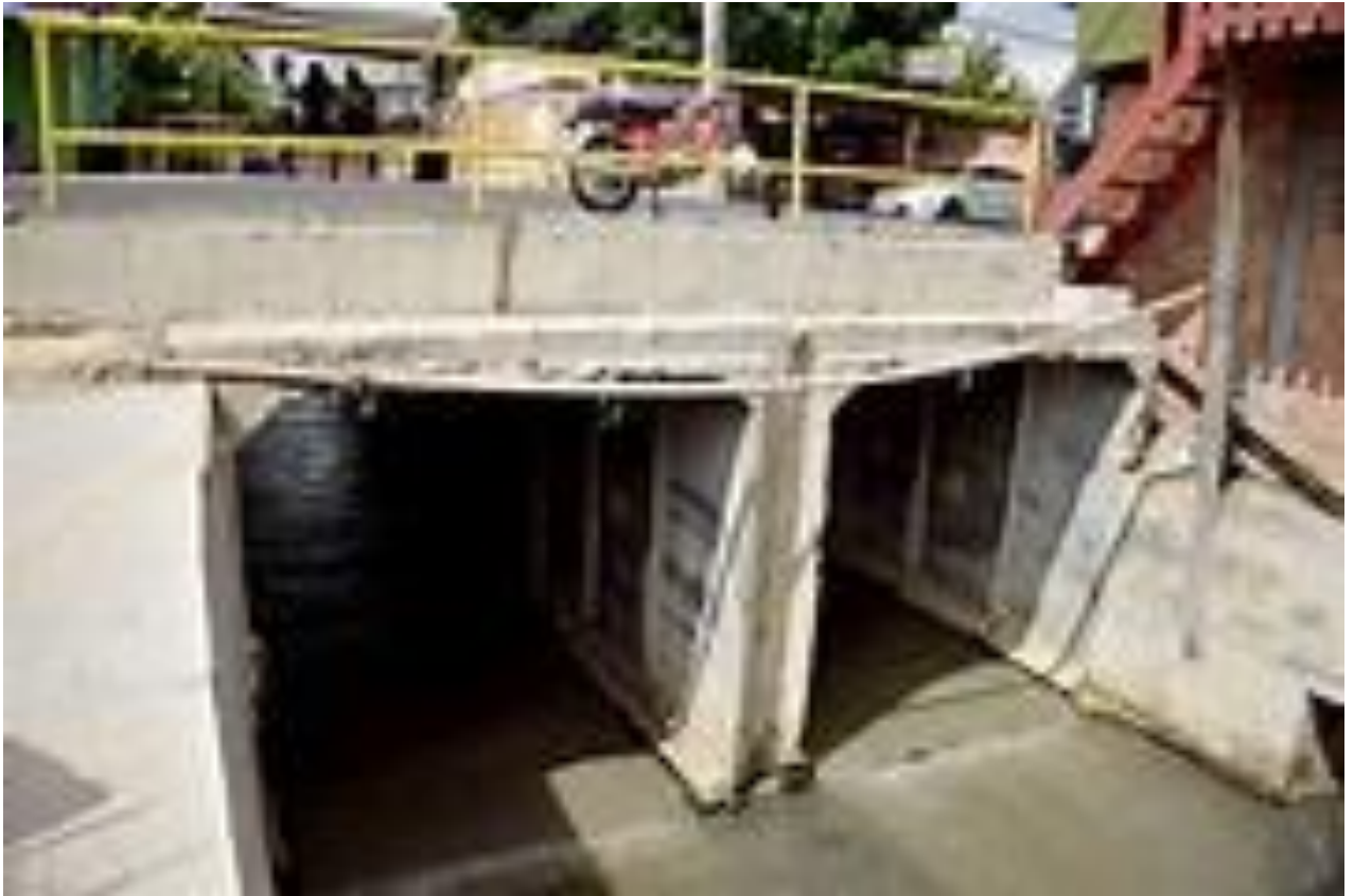
FOTO Nº 4: VISÃO PANORÂMICA DE PONTE EM ADUELAS DE CONCRETO ARMADO
