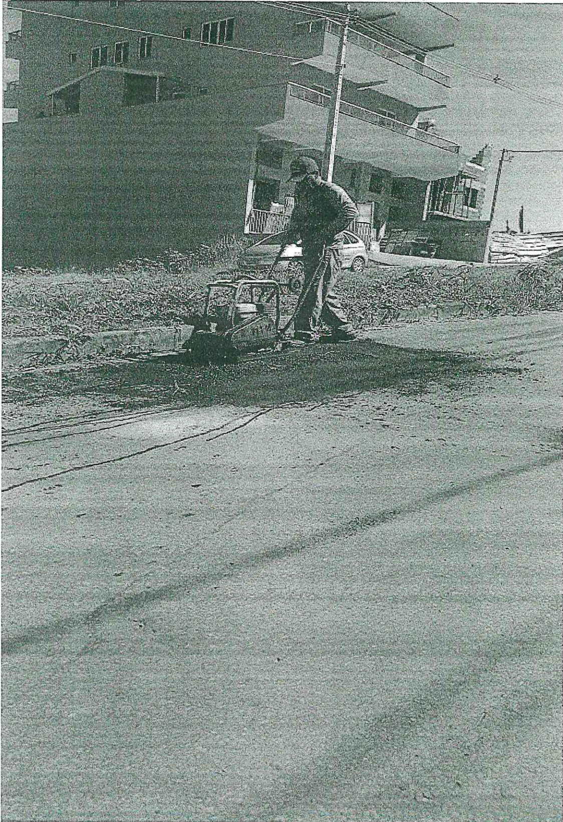
Foto nº 10 – Imagem panorâmica etapas de Operação Tapa buracos – OTB – Compactação massa aplicada
