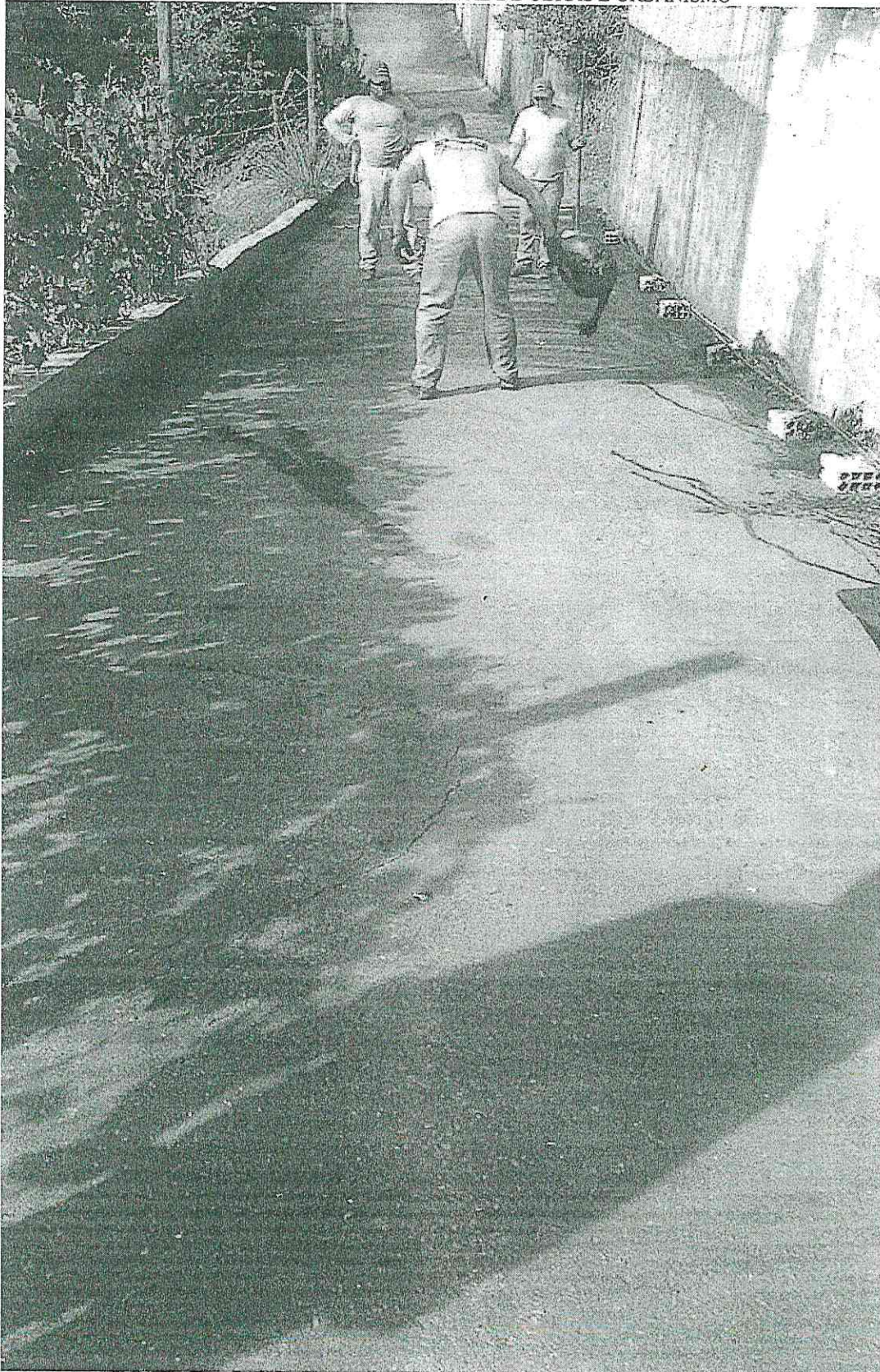
Foto nº 07 – Imagem panorâmica etapas de Operação Tapa buracos – OTB – Pintura de ligação
