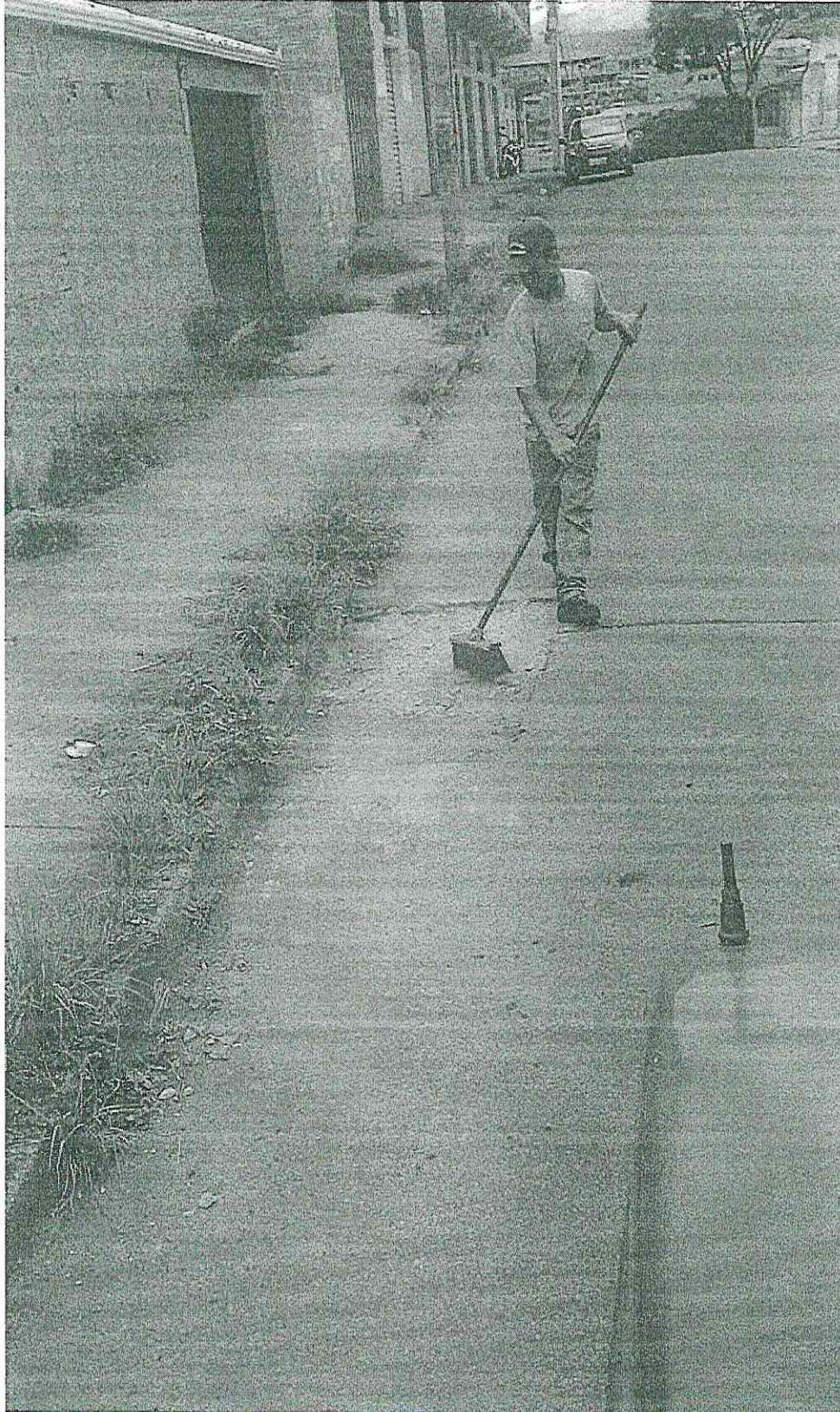
Foto nº 06 – Imagem panorâmica etapas de Operação Tapa buracos – OTB – Limpeza do local
