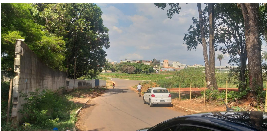
Foto 3: Visão panorâmica da via de instalação das novas aduelas – Rua Amileto Magnava
