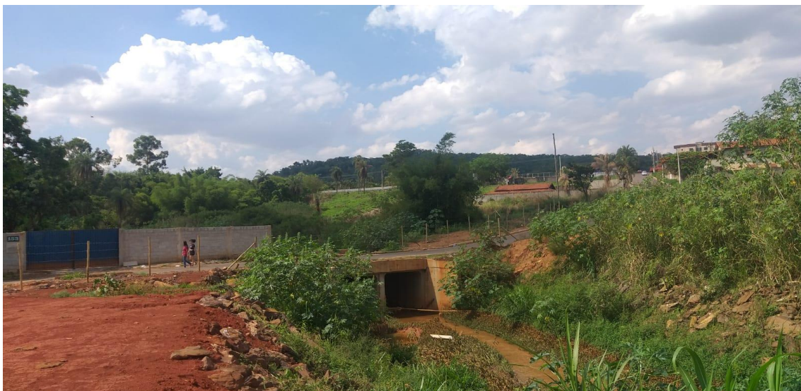
Foto 2: Visão panorâmica do local da instalação das novas aduelas, com o objetivo de aumento da vazão do Córrego Ribeirão Sarzedo
