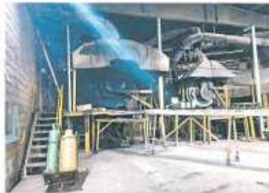
Foto 03 e 04: Coifa em fase de instalação, porem nota-se precariedade do sistema alimentador da coifa. Obs.: Foto 04: cilindro de hidrogênio utilizado para solda próximo aos fornos que operam em até 800°.
