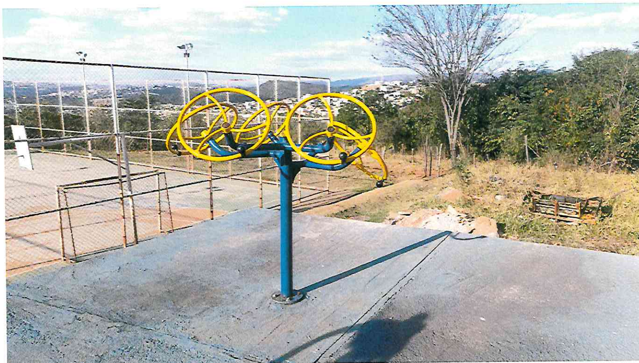
Foto 10 – Detalhamento dos equipamentos com necessidade de recuperação e pintura
