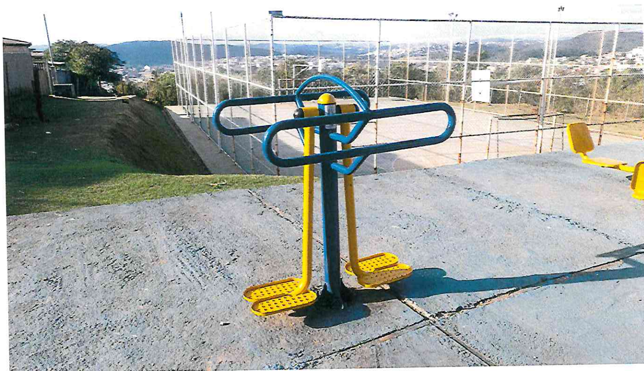
Foto 8 – Detalhamento dos equipamentos com necessidade de recuperação e pintura
