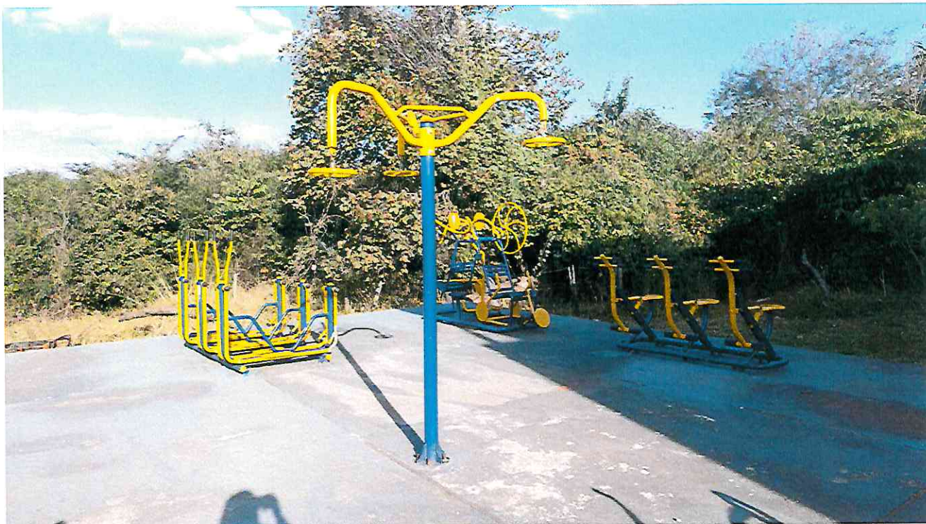
Foto 12 – Detalhamento dos equipamentos com necessidade de recuperação e pintura
