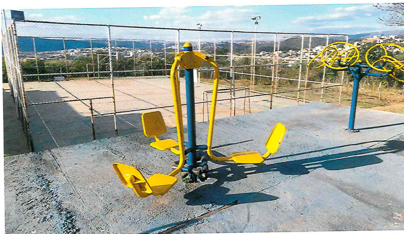
Foto 9 – Detalhamento dos equipamentos com necessidade de recuperação e pintura
