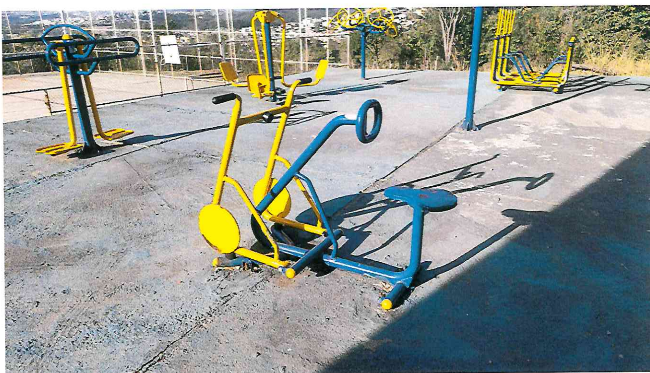
Foto 11 – Detalhamento dos equipamentos com necessidade de recuperação e pintura
