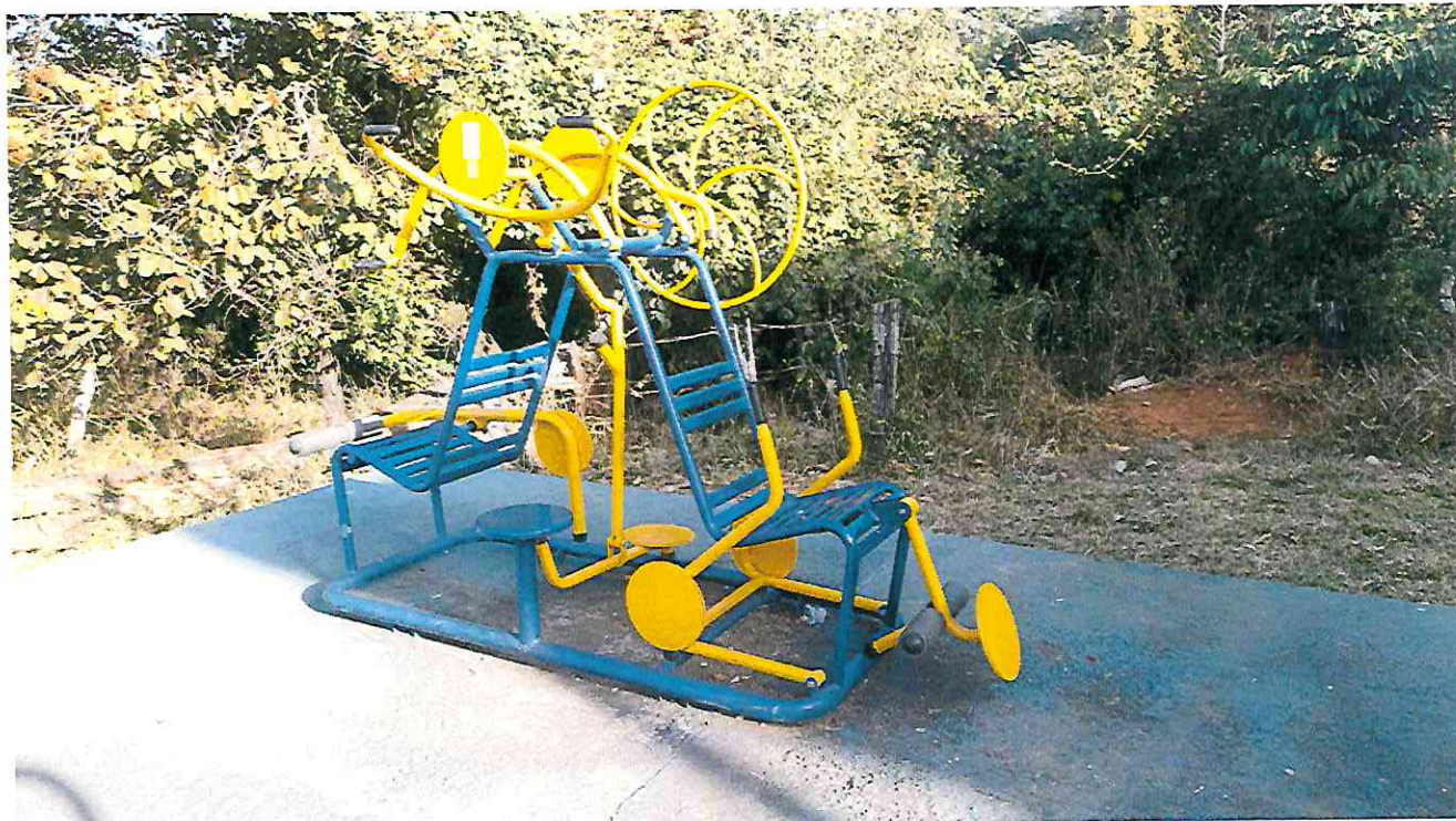
Foto 16 – Detalhamento dos equipamentos com necessidade de recuperação e pintura
