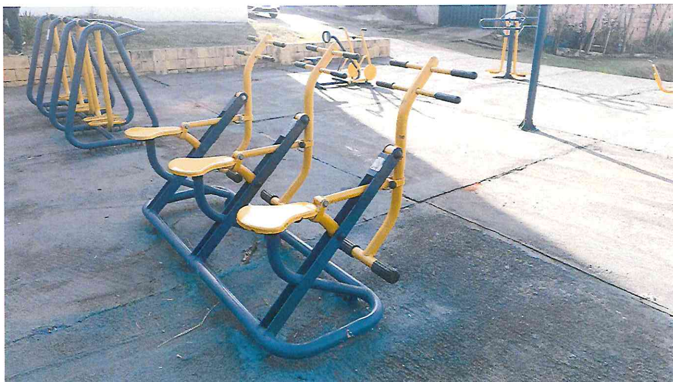
Foto 15 – Detalhamento dos equipamentos com necessidade de recuperação e pintura
